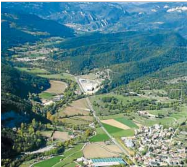
Una vista aèria de la carretera de Gombrèn a la zona de Campdevàrol, que és on s'inicien les obres ■ EL PUNT AVUI
