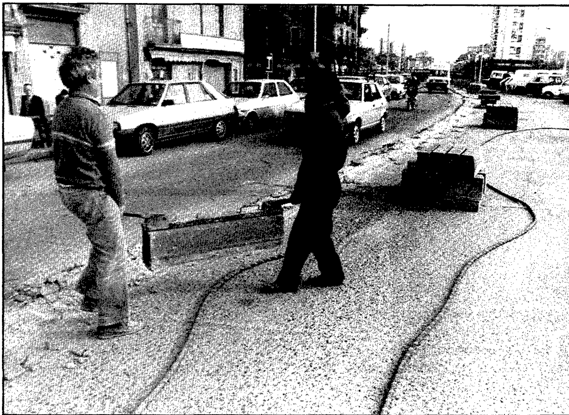
Ahir van ser retirades totes les peces de formigó de la plaça de Catalunya, però seran substituïdes per altres de més baixes. (Foto: Xevi Ruiz)
