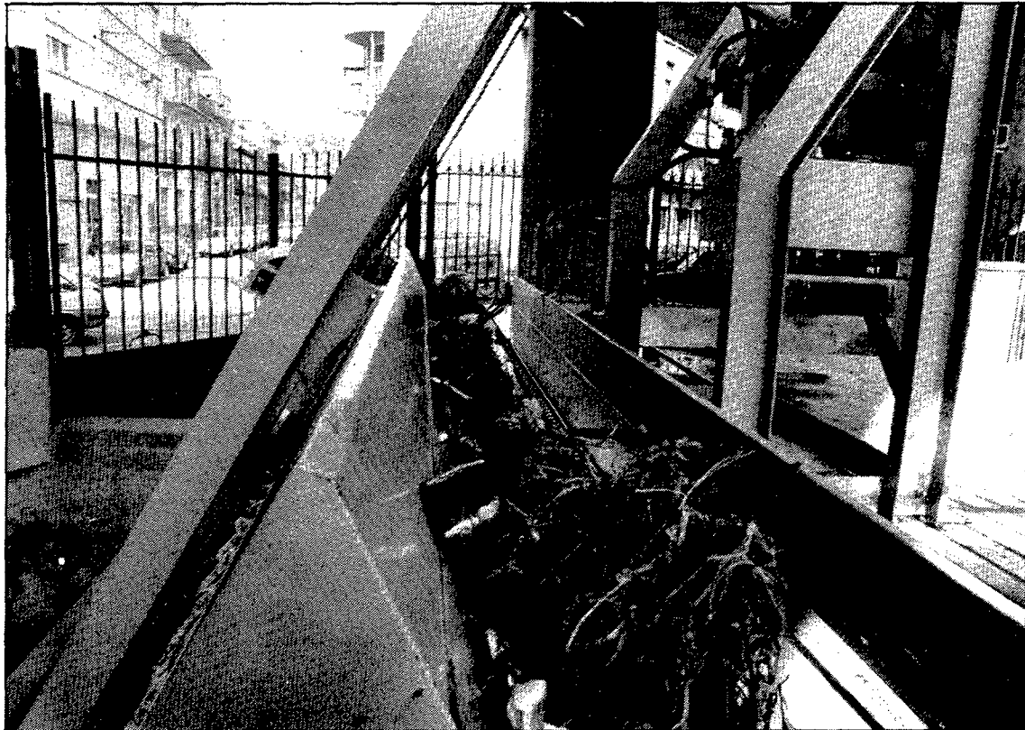
El dispositiu automàtic de neteja de la Sèquia, instal·lat al carrer Bernat Boades, serà canviat perquè s'espantia massa sovint.
