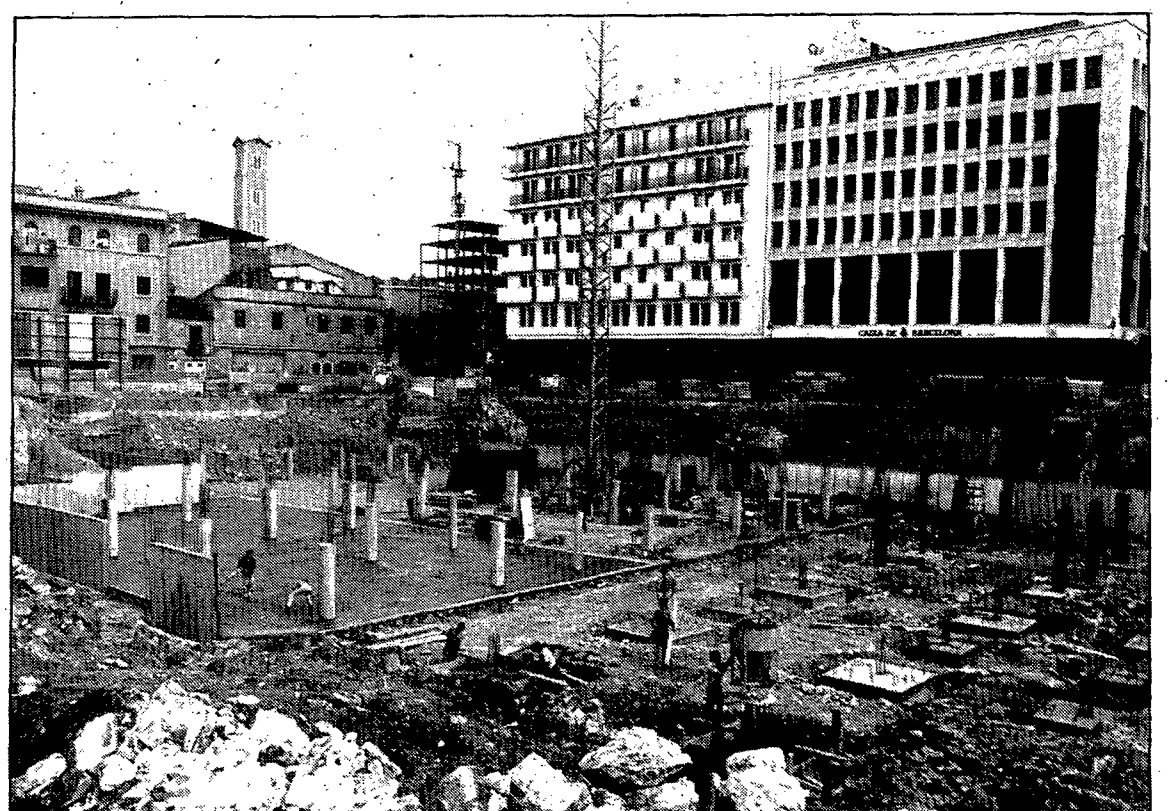
Continúan las obras en el parking de la plaza Constitución. — Las obras del parking subterráneo de la plaza Constitución de nuestra ciudad continúan a un buen ritmo y ahora ya comienza a vislumbrarse su estructura. Los trabajos de construcción de este nuevo parking subterráneo para automóviles se encuentran en su primera fase y, una vez finalizados, permitirán poner en marcha una segunda fase en la que acabará de concretarse su ejecución final. Este parking de la plaza Constitución enlazará, mediante un vía, con el subterráneo de la plaza Josep Pla, que ya funciona desde hace unos meses a un ritmo aceptable. Una vez se pongan en marcha estos dos nuevos aparcamientos subterráneos, se cubrirá una gran demanda de aparcamiento en este sector del centro de la ciudad. (Foto DAVID QUINTANA).
