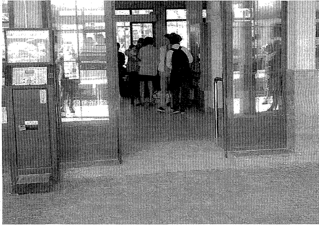
Unes rampes han substituït l'esgraó per accedir a l'estació, des del carrer i des de les andanes. Foto: J. PUIGBERT.
