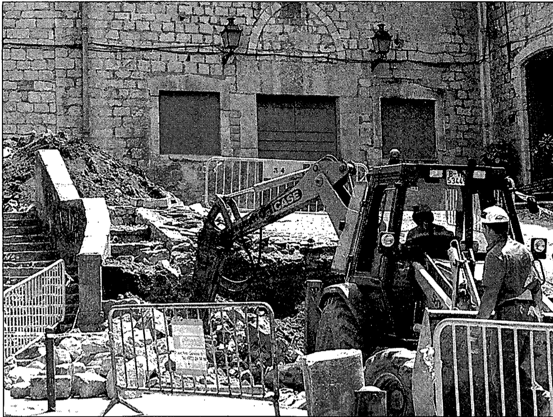
La pujada de la Mercè, ahir, aixecada per les obres de reurbanització del barri. Foto: MANEL LLADÓ.
