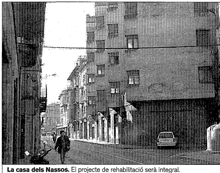
La casa dels Nassos. El projecte de rehabilitació serà integral.
