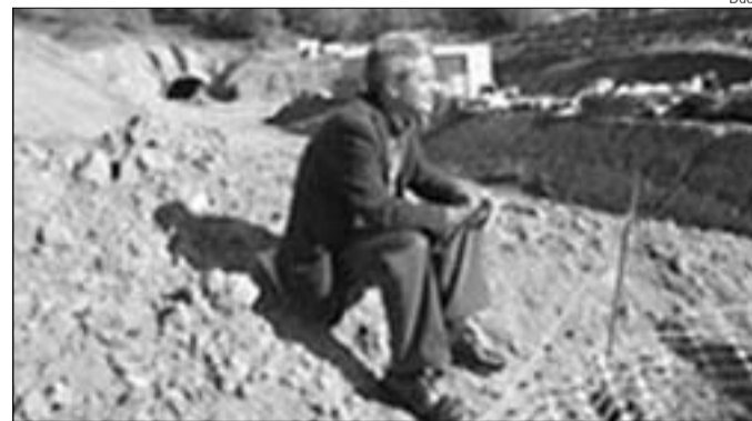
Visita. Joan Saura va visitar ahir les obres el túnel de Bracons
