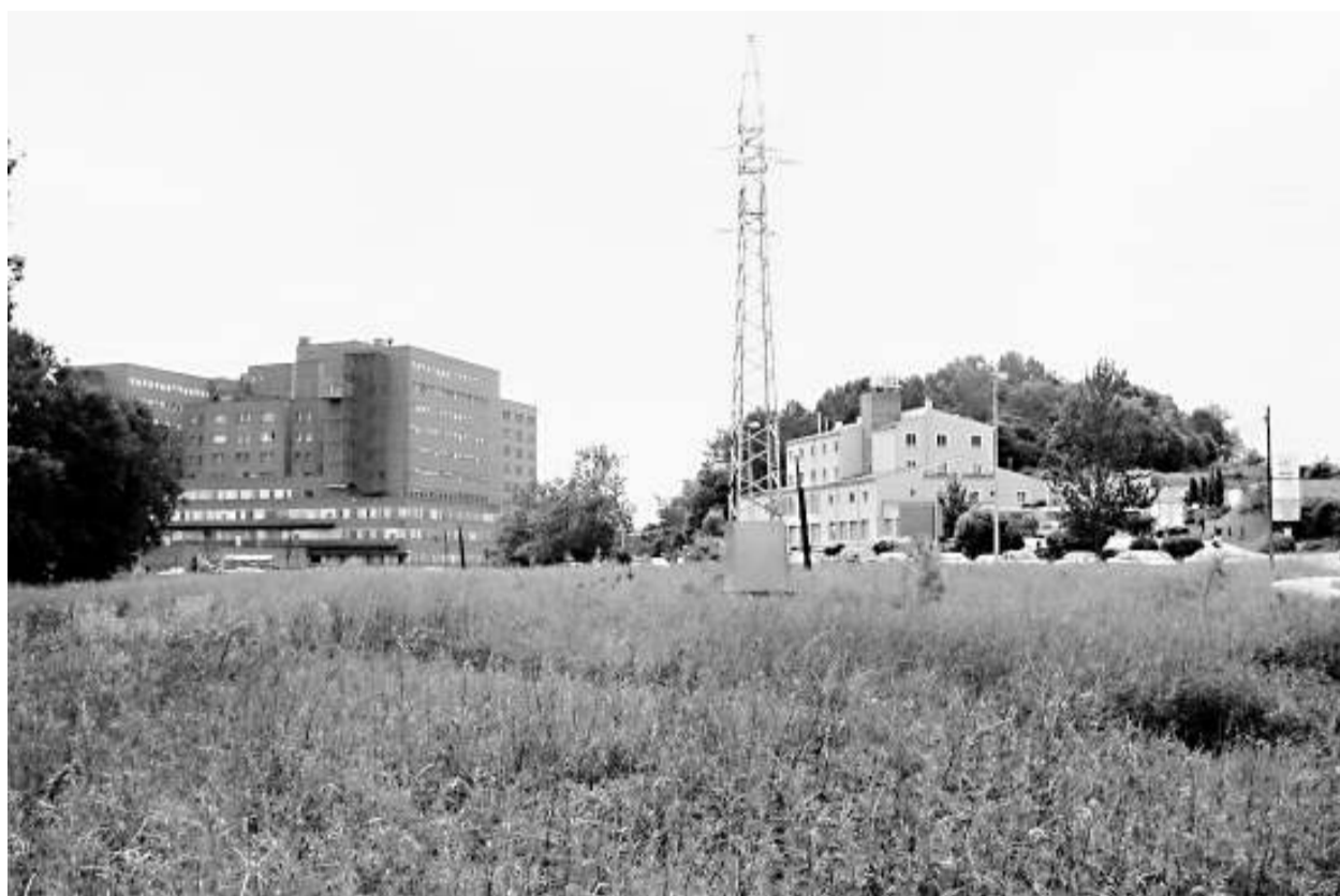
El terreny on es construirà el nou aparcament, amb l'hospital Josep Trueta al fons. / D. BRUGUÉ.
