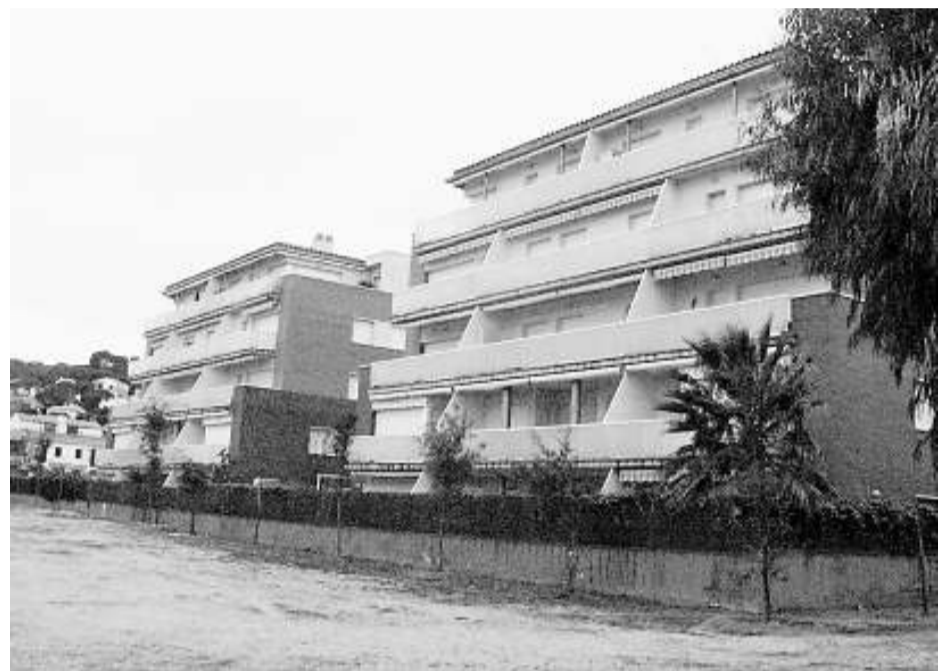
Vista general dels dos edificis Llevantí de Mar que una sentència diu que s'han d'enderrocar. / A.V.
