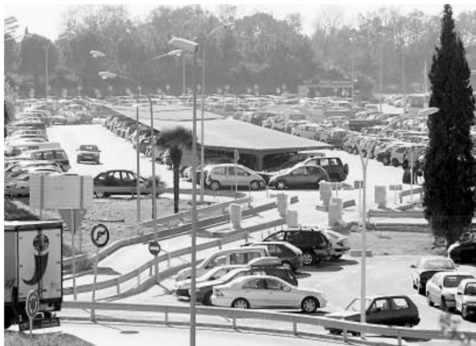
La construcció del nou aparcament de l'aeroport s'acabarà a finals de febrer. / EUDALD PICAS
