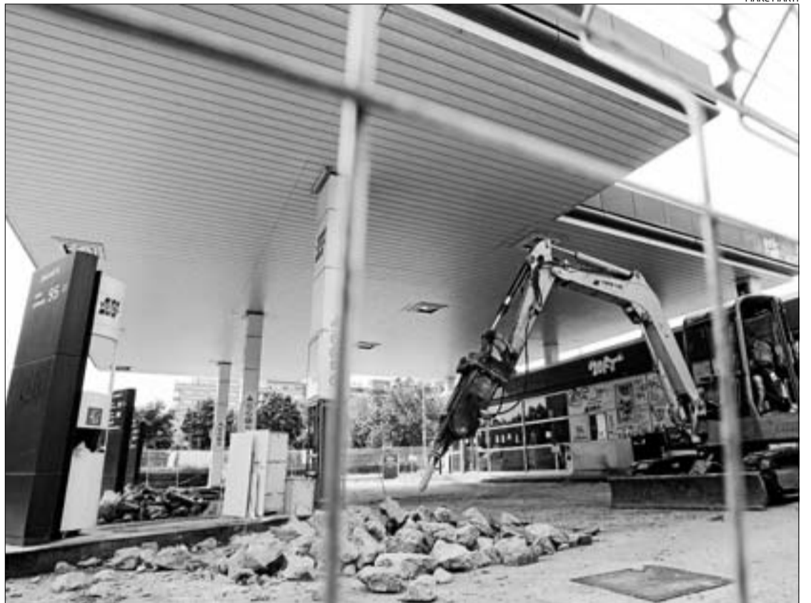
La màquina va treballar ahir per obrir forats a l'espai on fins fa poques setmanes repostaven els vehicles.
