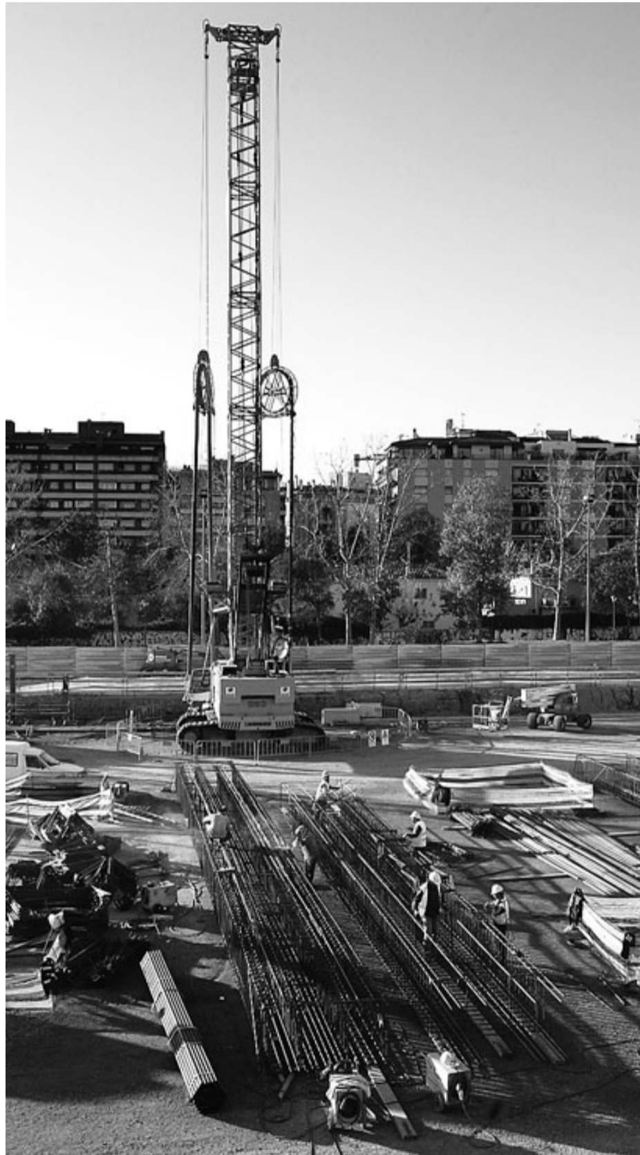
La màquina que fa les pantalles de formigó al parc Central de Girona. / LLUÍS SERRAT
