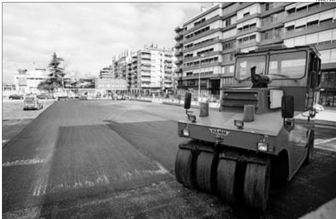
El futur aparcament a la cruïlla entre Emili Grahit i la carretera Barcelona s'està asfaltant.
