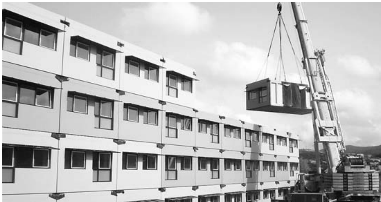
Un moment del muntatge, ahir al matí, dels mòduls prefabricats que seran pisos per a estudiants universitaris ■ N.A.
