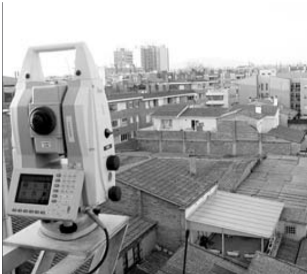
Vista del sector Güell-Devesa, per on passarà la tuneladora, amb un dels dispositius de control del TAV ■ D.V.
