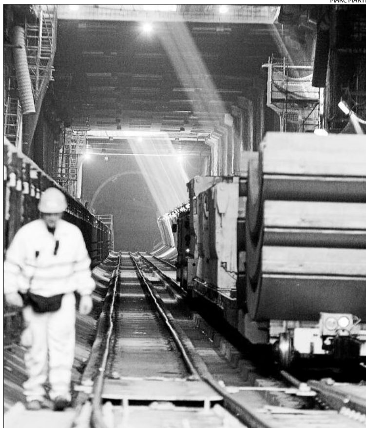
Moviment ► Un operari en un tram de túnel on ja hi ha la via del TAV -a l'esquerra- mentre dos treballadors es desplacen per l'interior de la tuneladora -dreta-.
