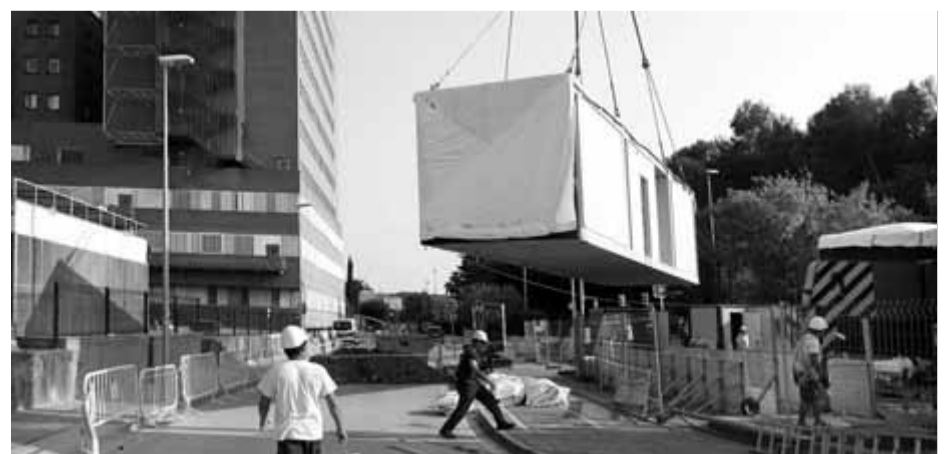
Uns operaris instal·len un dels mòduls prefabricats, on se situaran les consultes externes de l'hospital Josep Trueta, ocupant la meitat del pàrquing de Mifas ■ LLUÍS SERRAT
