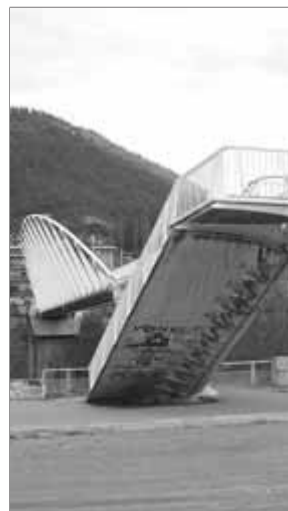
El pont de l'arquitecte Calatrava, a Ripoll ■ J.C.
