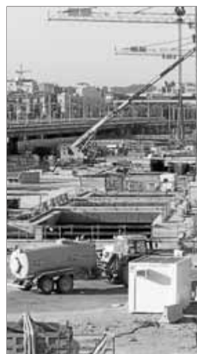
Un detall de les obres al parc Central ■ J. SABATER
