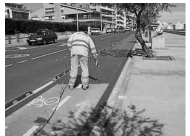
Un operari pintant de color vermell el carril bici del passeig de l'Escala ■ EL PUNT AVUI
