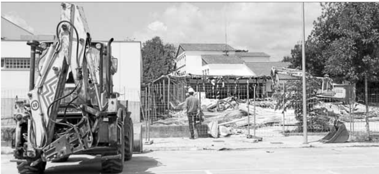
Els treballs de demolició de l'institut antic, ahir al migdia, al fons de la imatge, i l'edifici nou, a l'esquerra ■ E.A.
