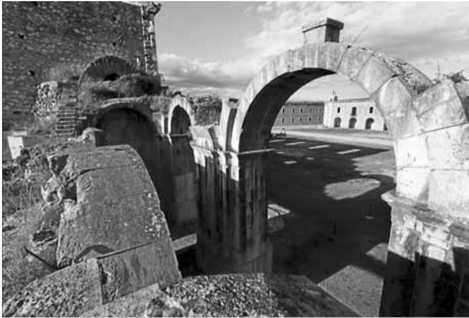
Les obres al castell de Sant Ferran de Figueres duraran tres mesos ■ LLUÍS SERRAT
