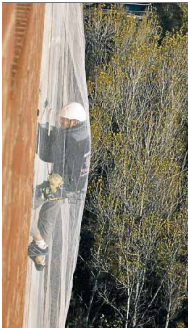
Un dels operaris que du a terme les obres, penjat amb cordes i arnesos, a la façana que dona al riu ■
