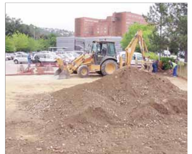
Els treballs d'ampliació de l'aparcament del Trueta han començat fa pocs dies i permetran crear trenta places ■ D.V.
