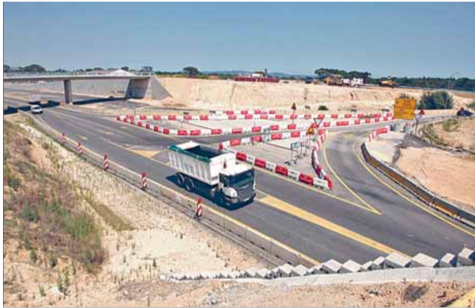
Obres a l'N-II, en el tram de Caldes, en una imatge d'arxiu ■ JOAN SABATER
