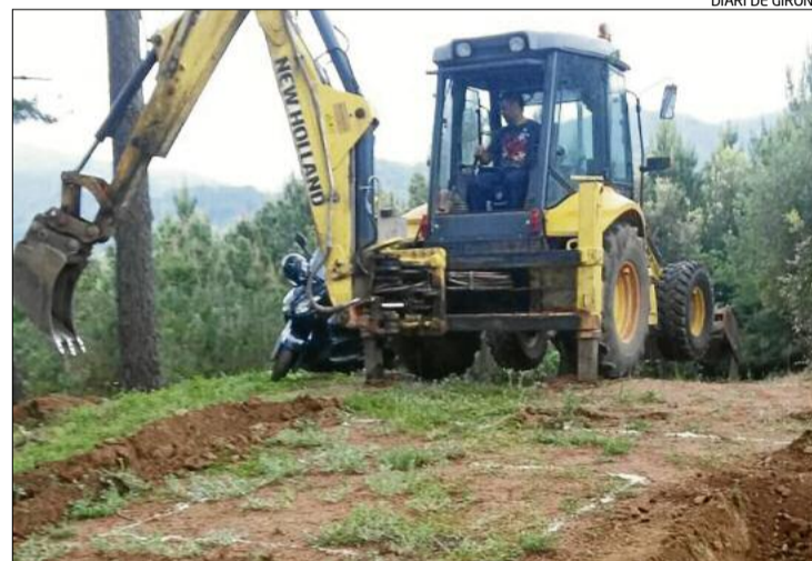
Una màquina treballant aquesta setmana en els fonaments de la torre.
