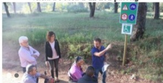
Visita a l'obra d'un nou passeig
