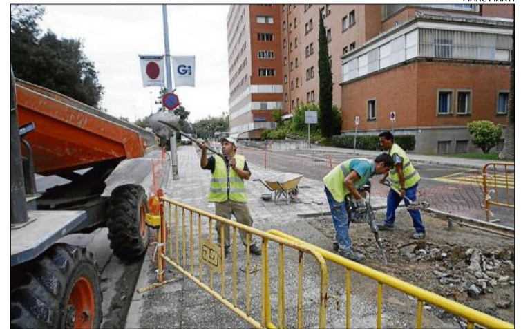
Obres al tram pendent del carril bici davant del Trueta.
