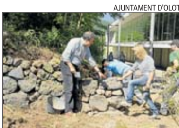
Un moment de la construcció.
