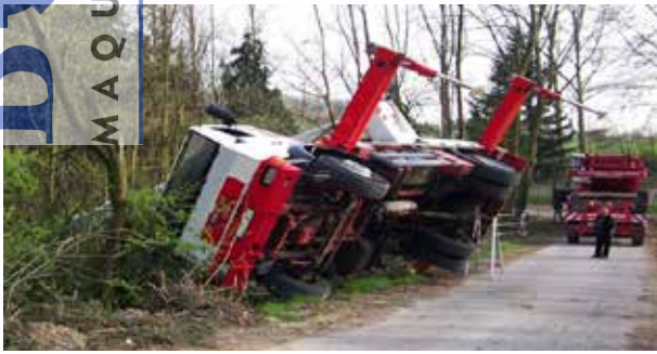
Figura 9. PEMP sobre camión volcado por efectuar trabajos sobre una superficie en mal estado o de poca resistencia
