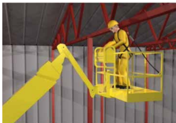
Figura 20. Atrapamiento contra objetos fijos en la fase de elevación de la plataforma
