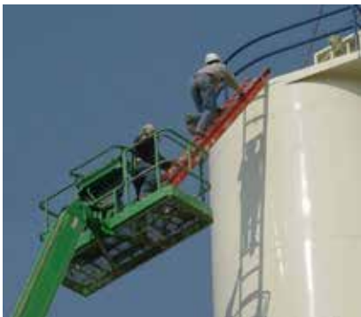
Figura 10. Acceso a una estructura utilizando medios auxiliares
