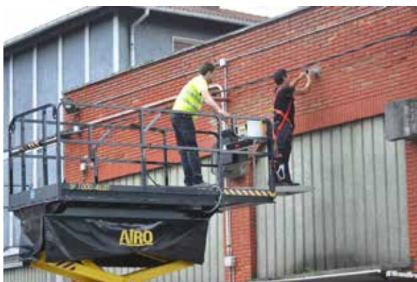
Figura 16. Plataforma con superficie aumentada con una estructura adicional
