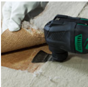
Extracción de mortero / adhesivo
